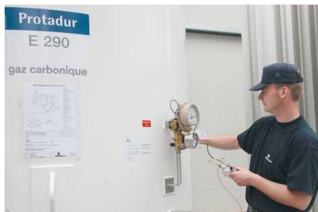
Formés à la sécurité. Nos collaborateurs du Service Après-Vente sont partout et toujours en action pour vous.
