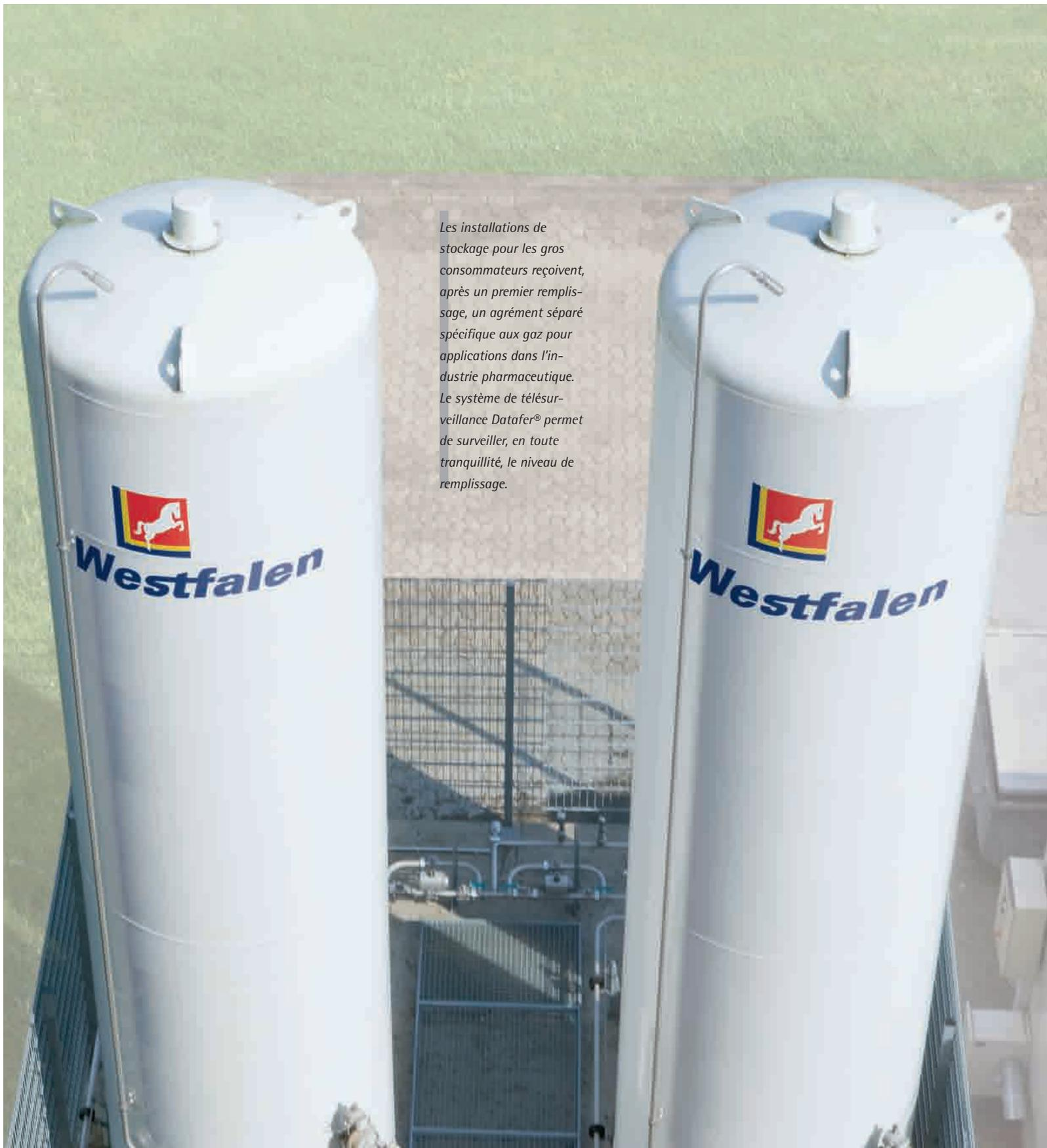
*Les installations de stockage pour les gros consommateurs reçoivent, après un premier remplissage, un agrément séparé spécifique aux gaz pour applications dans l'industrie pharmaceutique. Le système de télésurveillance Datafer® permet de surveiller, en toute tranquillité, le niveau de remplissage.*
